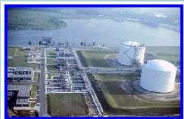
Lake Charles (LA) LNG Import Terminal
